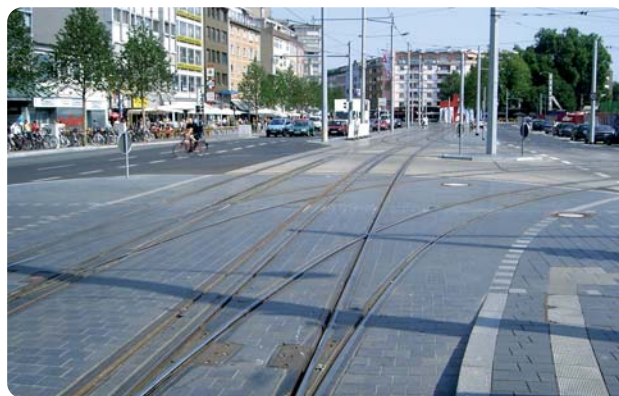
3-Schienen-Gleise in Braunschweig
